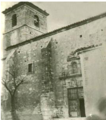
(2) Fachada sur. Ca. 1940-1950
