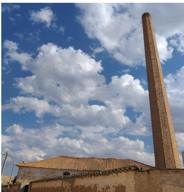
(1) Chimenea de la extractora. Año 2020
